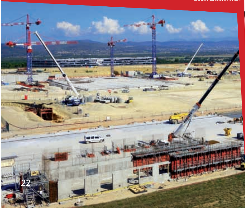
Budowa Międzynarodowego Eksperymentalnego Reaktora Termojądrowego, sierpień 2013. Źródło: ITER
